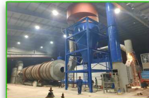
Lắp dựng cấu kiện
