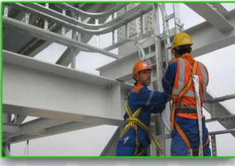
Thi công hệ thống điện
