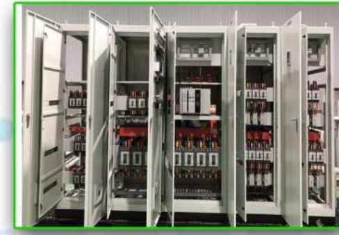
Lắp ráp tủ điện
