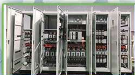
Lắp ráp tủ điện
