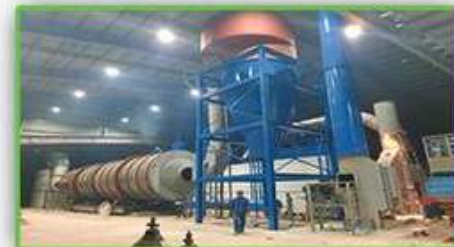
Lắp dựng cấu kiện
