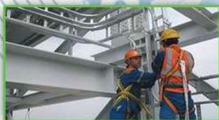
Thi công hệ thống điện
