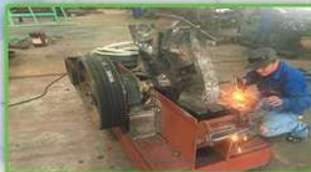
Sửa chữa thiết bị
