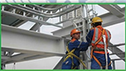
Thi công hệ thống điện
