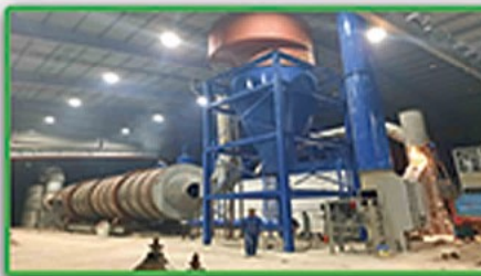
Lắp dựng cấu kiện
