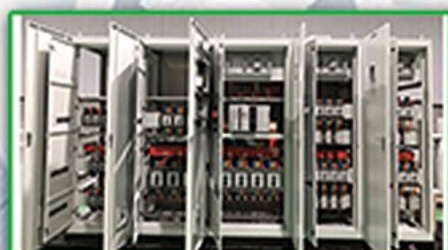
Lắp ráp tủ điện
