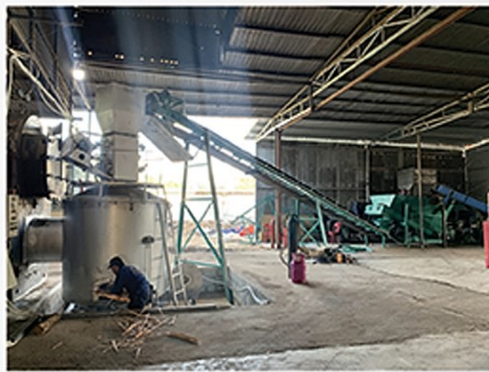
LÒ ĐỐT CHO LÒ HƠI 4 TẤN
